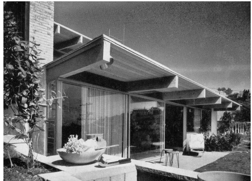
FIG. 383: FACHADA POSTERIOR Y TERRAZA / FOTO SCHULMAN.
