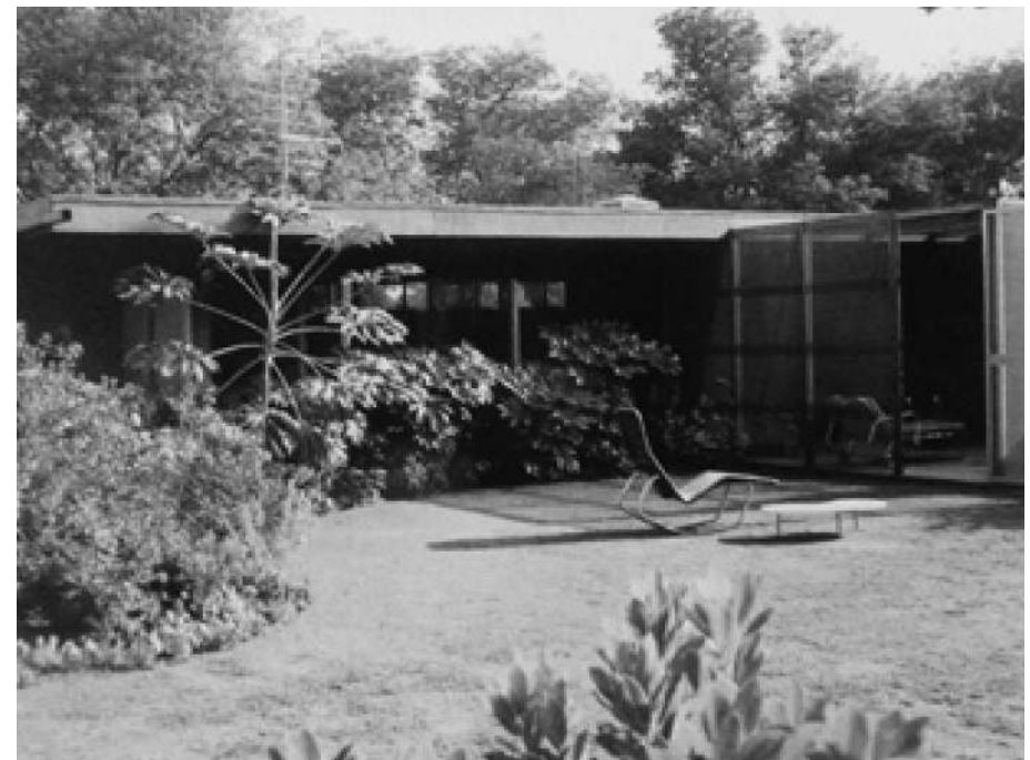
FIG. 110: FACHADA POSTERIOR / FOTO SCHULMAN.
