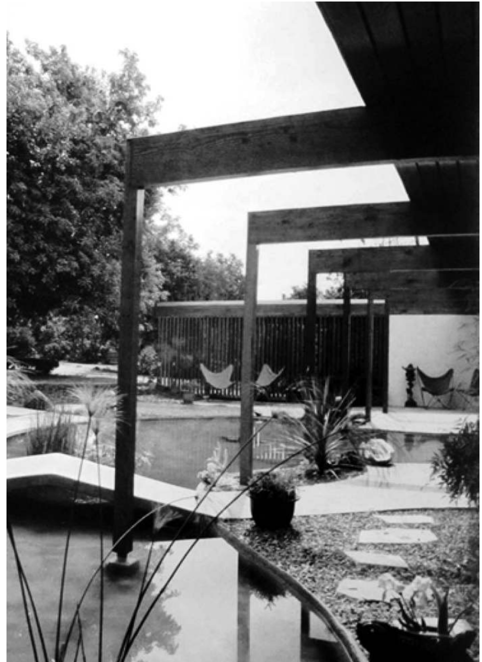
FIG. 742: DETALLE DE PÓRTICOS (PATAS DE ARAÑA) Y VIGAS EXTERIORES / FOTO SCHULMAN.
