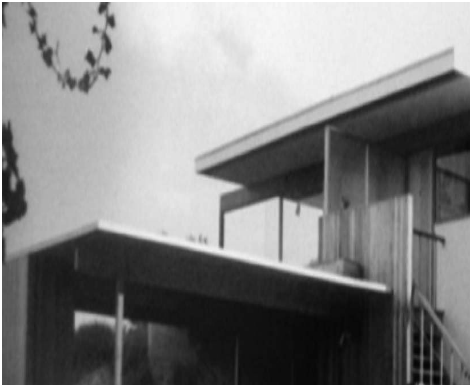
FIG. 471: DETALLE DE CUBIERTA / FOTO AMPLIADA SCHULMAN.
