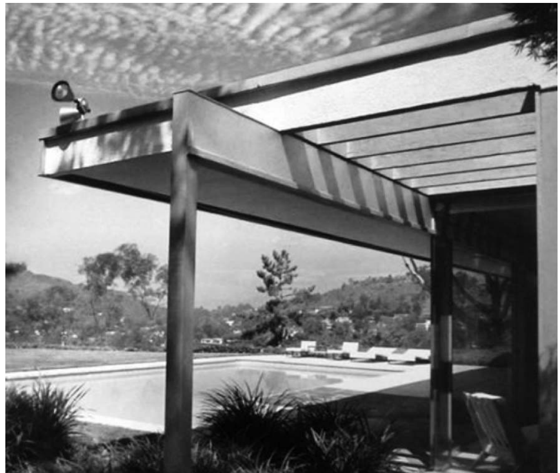
FIG. 874: DETALLE DE PILAR EXTERNO / FOTO SCHULMAN.
