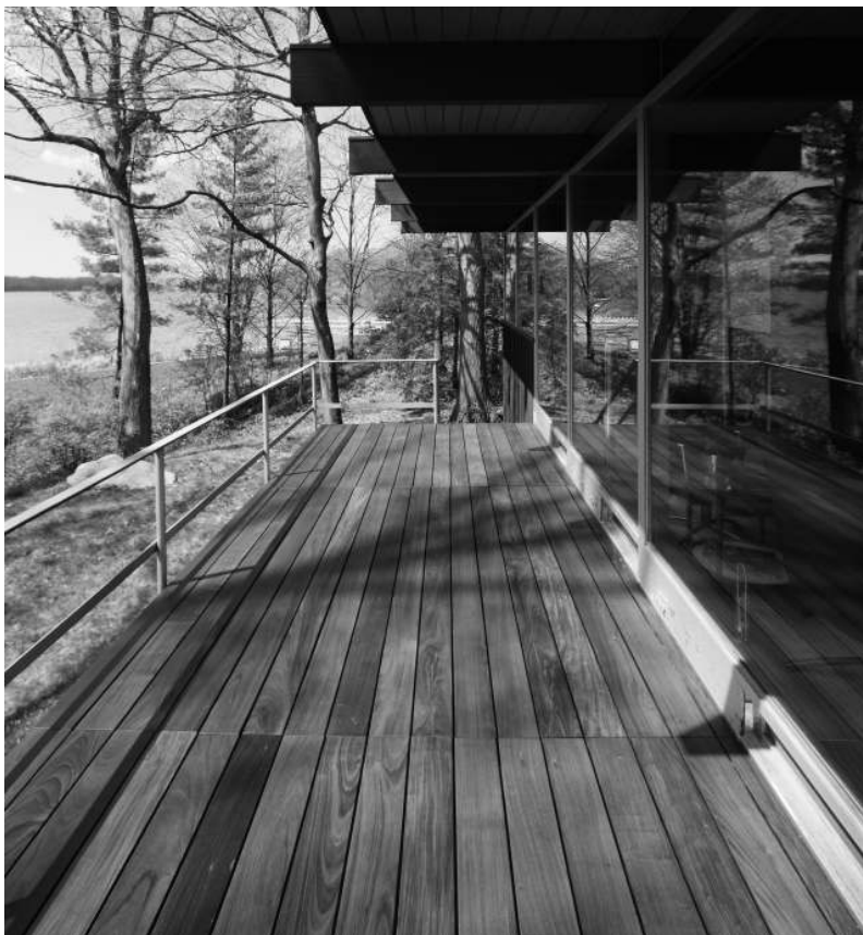
FIG. 1.144: TERRAZA Y CUBIERTA / FOTO SCHULMAN.
