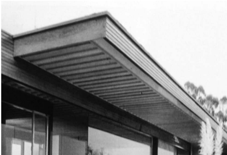
FIG. 268: DETALLE CUBIERTA / FOTO AMPLIADA SCHULMAN.
