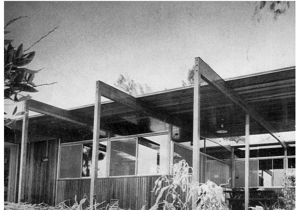
FIG. 474: VISTA FACHADA FRONTAL / FOTO SCHULMAN.
