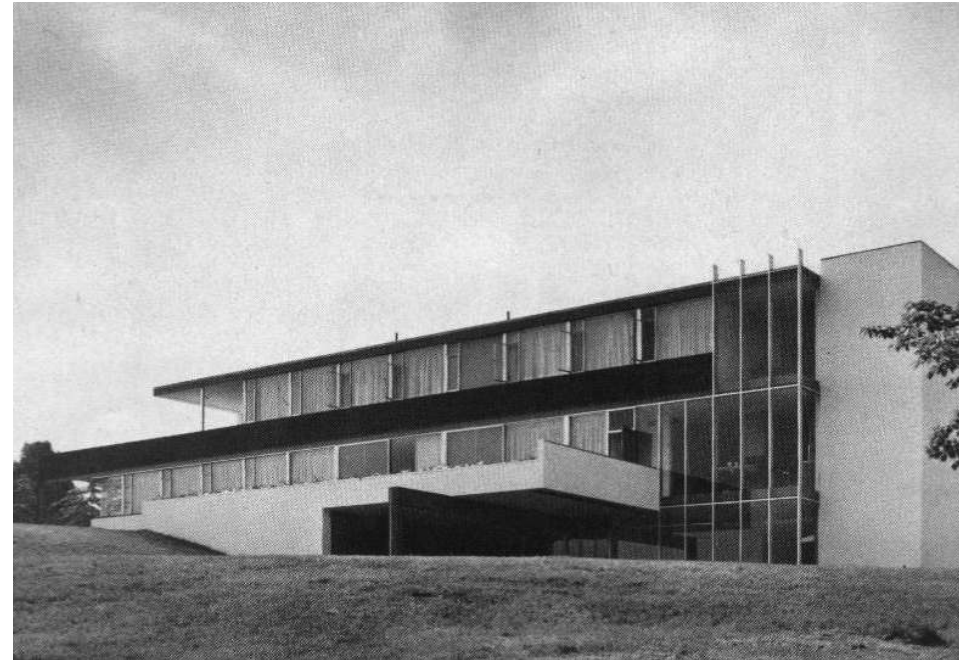
FIG. 779: FACHADA POSTERIOR / FOTO SCHULMAN.
