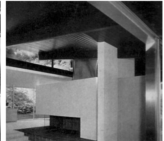
FIG. 511: DETALLE DE CUBIERTA / FOTO SCHULMAN.
