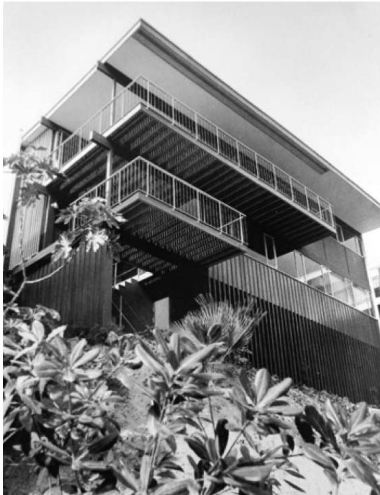
FIG. 855: FACHADA POSTERIOR / FOTO SCHULMAN.
