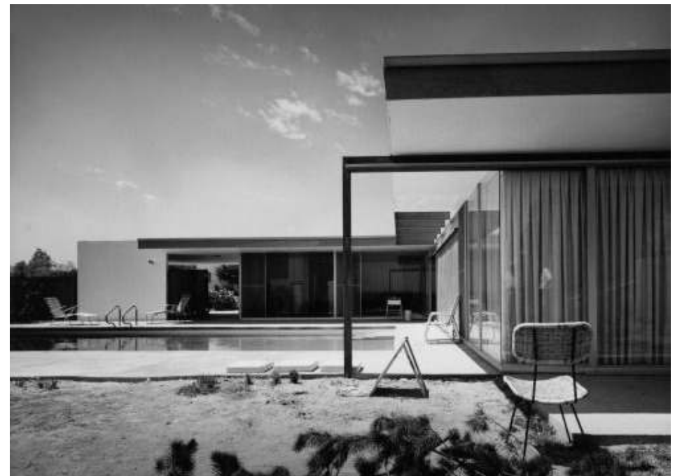
FIG. 912: FACHADA LATERAL / FOTO SCHULMAN.
