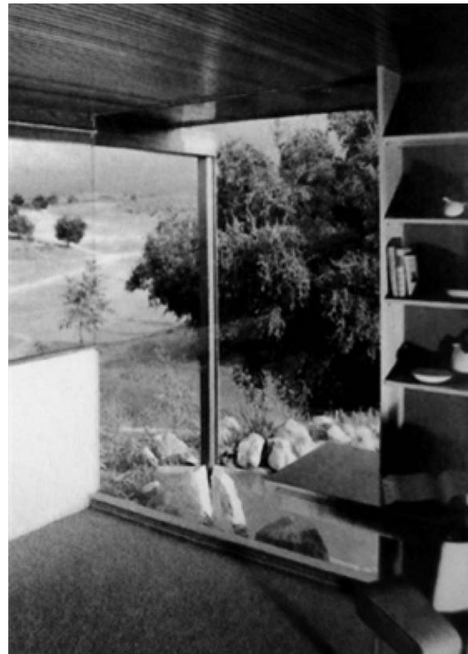
FIG. 325: PILAR Y VIGA EXTERNA (PATA DE ARAÑA) / FOTO SCHULMAN.
