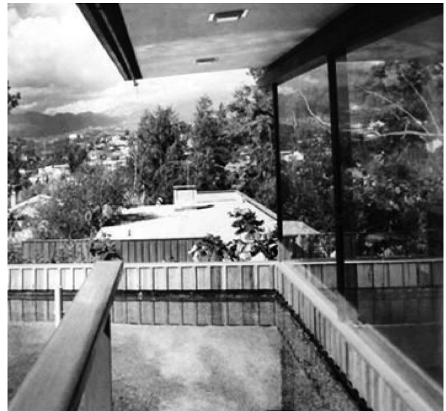
FIG. 777: DETALLE DE AVENTANAMIENTO / FOTO SCHULMAN.
