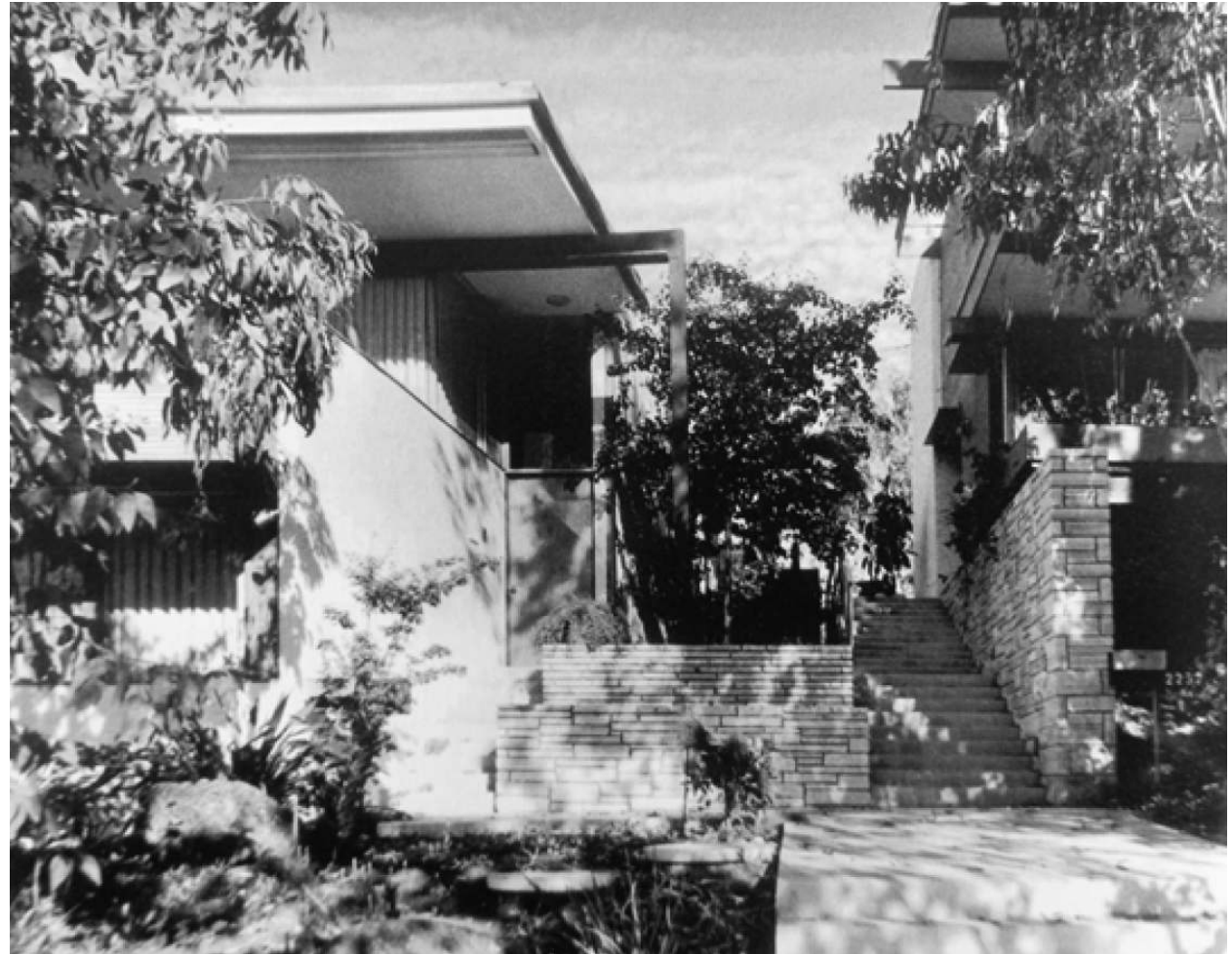
FIG. 1.036: VISTA DE CONJUNTO INGRESO A CASAS / FOTO RICHARD NEUTRA.
