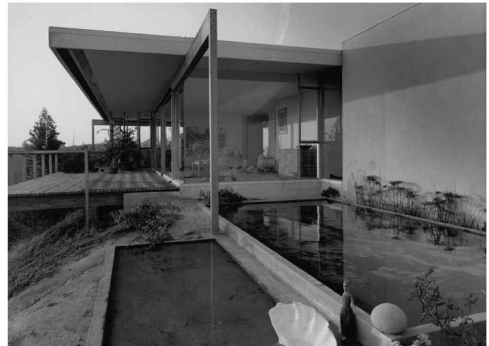
FIG. 532: INGRESO PRINCIPAL / FOTO SCHULMAN.
