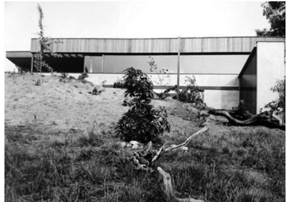
FIG. 180: FACHADA LATERAL / FOTO SCHULMAN.
