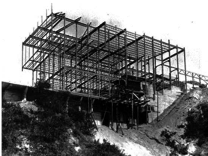
FIG. 3: CASA LOVELL – ESTRUCTURA METÁLICA (1927-1929).
