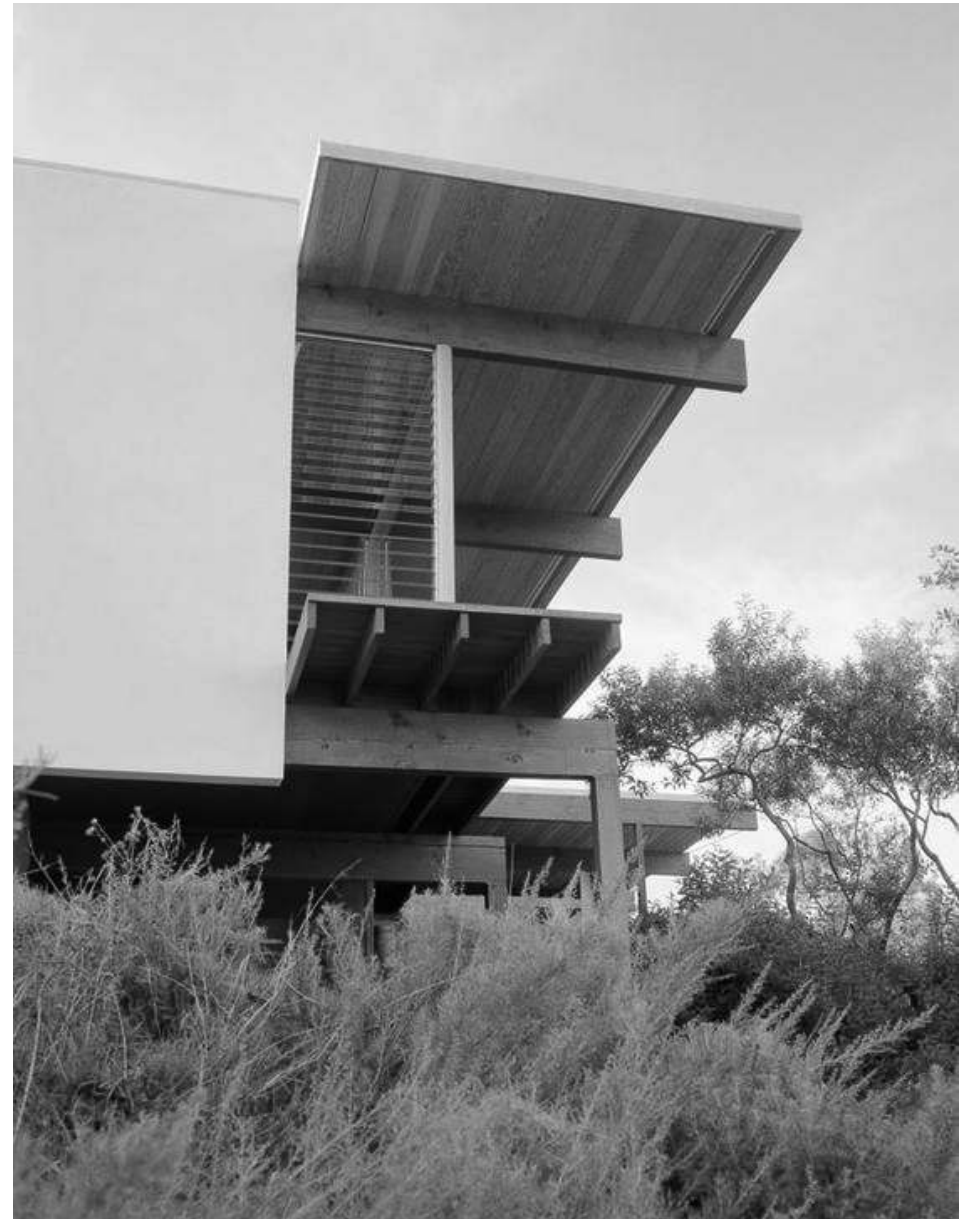
FIG. 40: VISTA LATERAL DE LA CASA TROXELL DE 1956.
