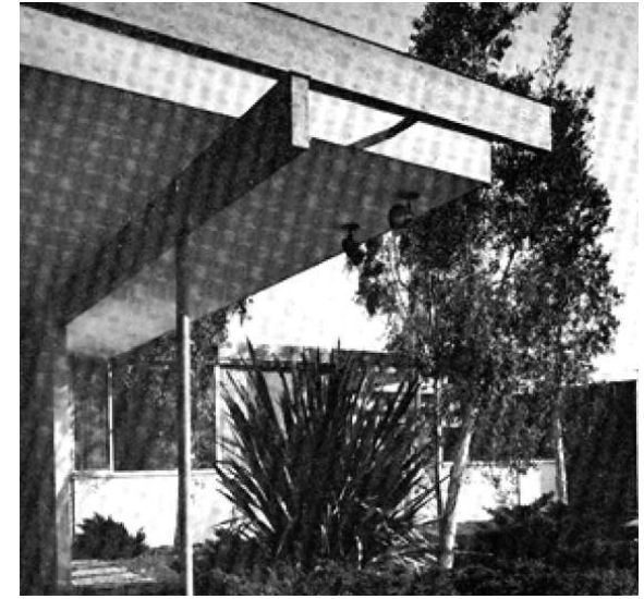
FIG. 702: DETALLE ENCUENTRO DE VIGA, PILAR Y CUBIERTA / FOTO SCHULMAN.
