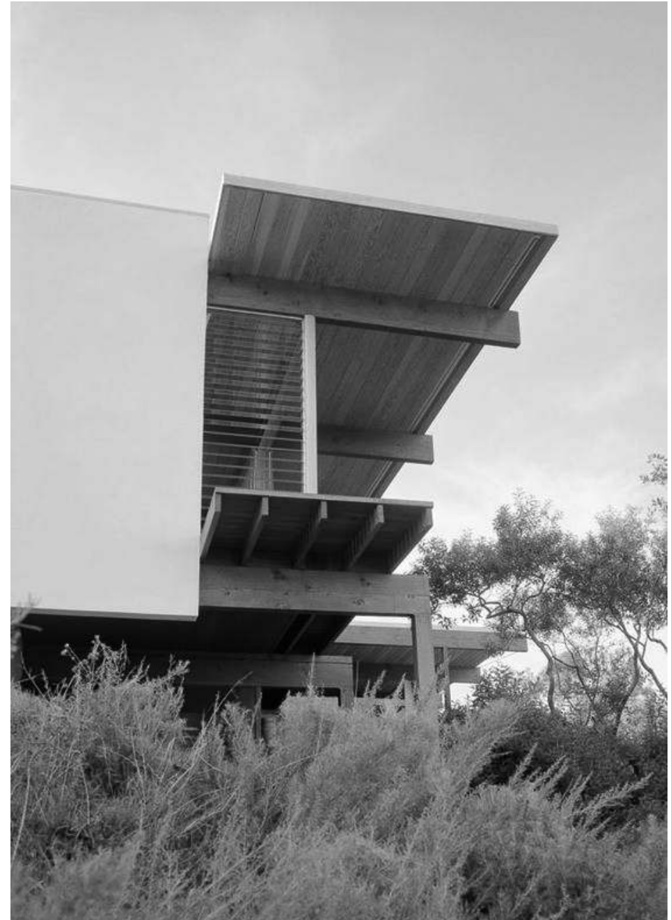
FIG. 664: DETALLE ESQUINA Y BALCÓN / FOTO SCHULMAN.
