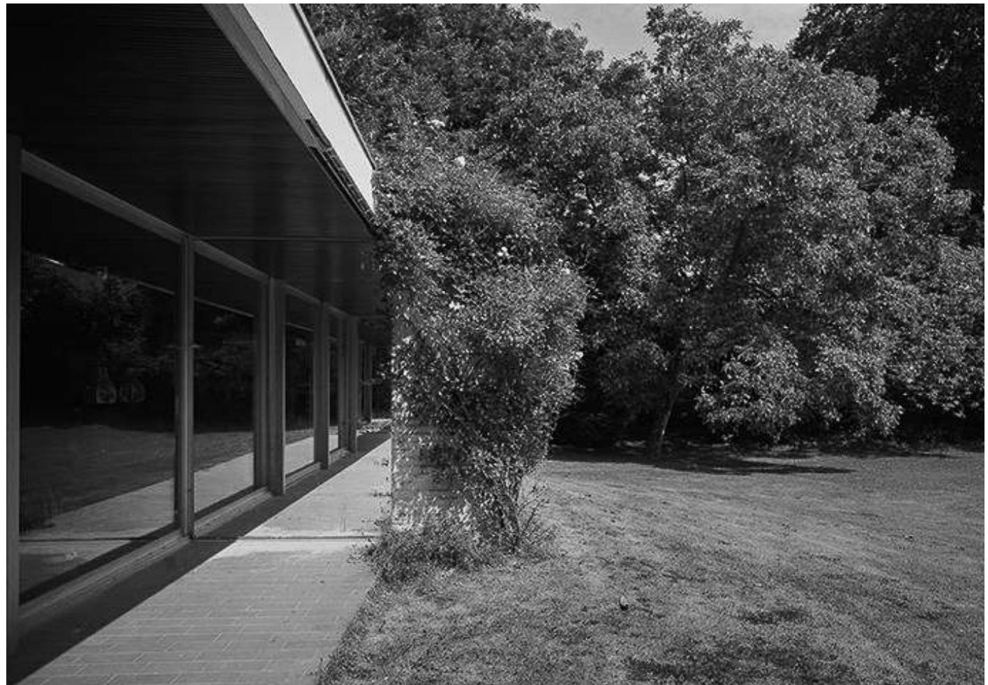
FIG. 1.202: FACHADA POSTERIOR / FOTO SCHULMAN.
