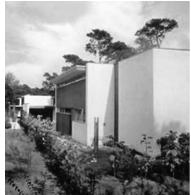
FIG. 985: VISTA DE CONJUNTO / BLOQUES HABITACIONALES / F. NEUTRA.
