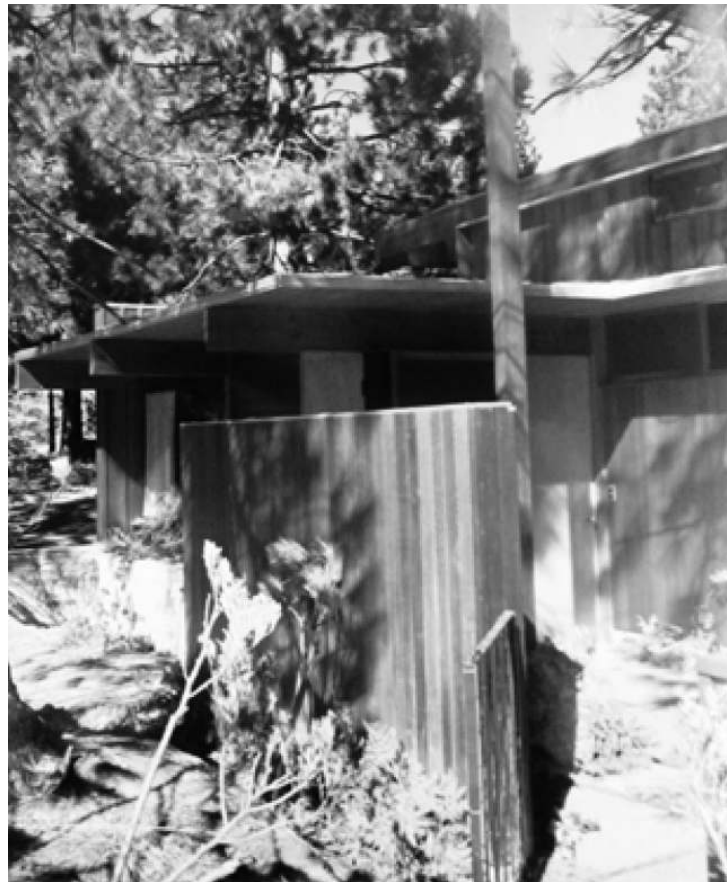
FIG. 249: INGRESO PRINCIPAL / FOTO SCHULMAN.
