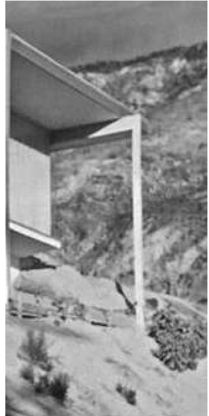
FIG. 721: DETALLE DE PILAR / FOTO SCHULMAN.
