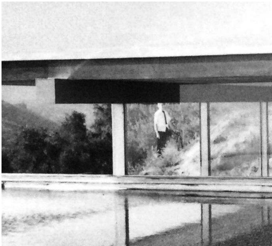
FIG. 432: DETALLE DE VIGAS EXTERNAS / FOTO AMPLIADA RICHARD NEUTRA.
