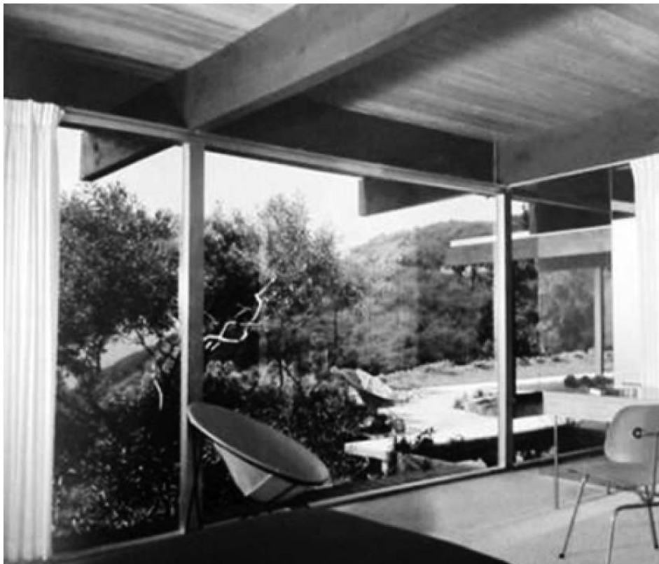
FIG. 679: DETALLE ENCUENTRO DE PILARES Y VIGAS / FOTO SCHULMAN.
