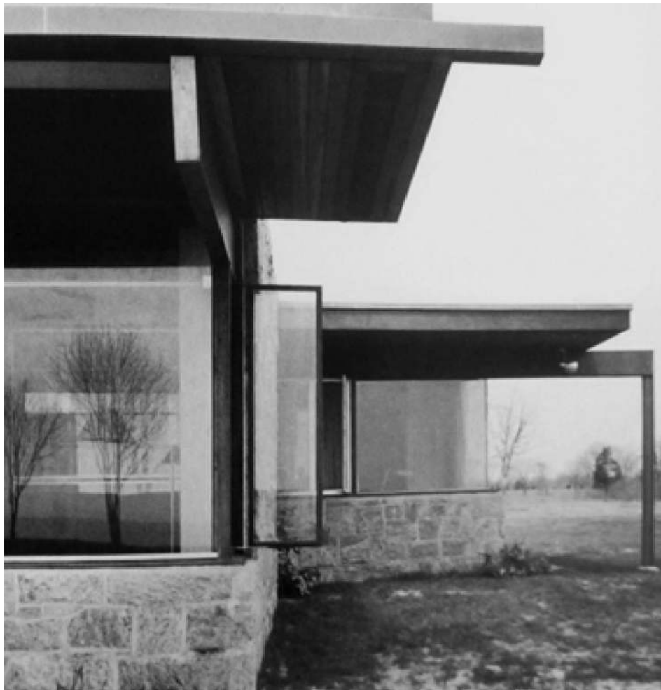
FIG. 362: EXTERIOR / VIGAS PILARES / FOTO SCHULMAN.
