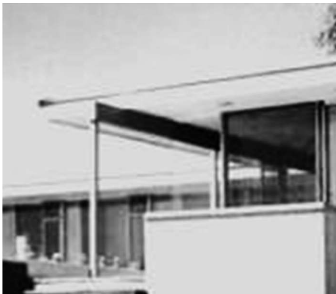
FIG. 800: DETALLE DE PILAR Y VIGA EXTERIOR / FOTO NEUTRA.
