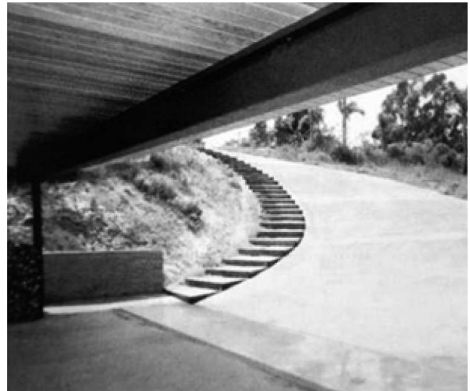
FIG. 681: INGRESO DEL GARAJE / FOTO SCHULMAN.
