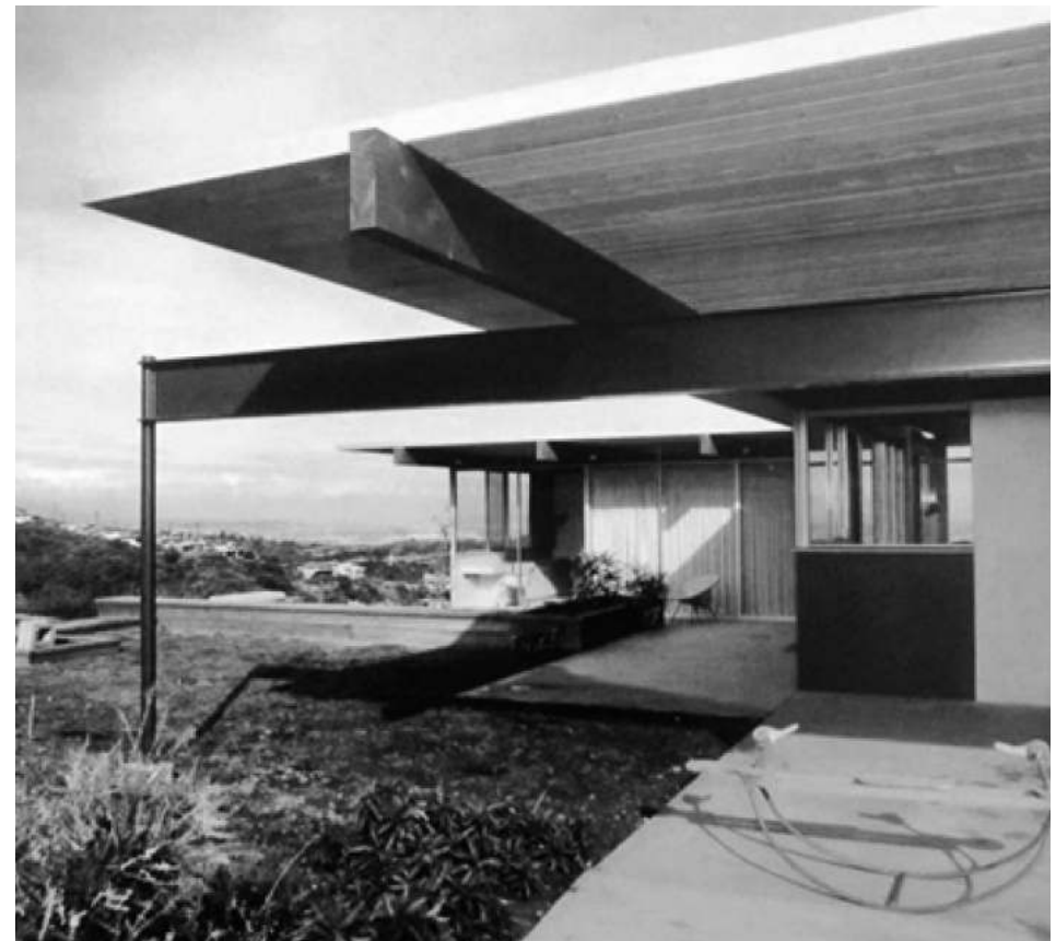
FIG. 515: VISTA DETALLE DE PILAR VIGA Y CUBIERTA / FOTO SCHULMAN.
