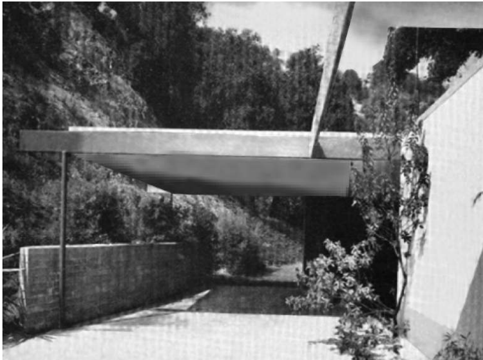
FIG. 1.259: ÁREA EXTERIOR GARAJE / FOTO SCHULMAN.
