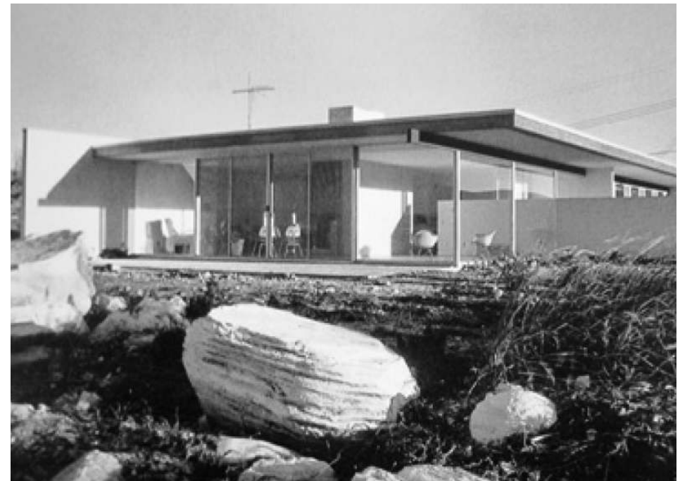
FIG. 894: FACHADA POSTERIOR / FOTO SCHULMAN.
