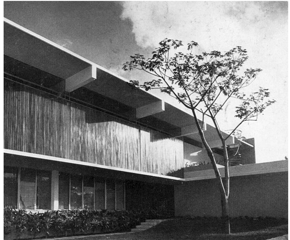
FIG. 641: FACHADA POSTERIOR / FOTO SCHULMAN.
