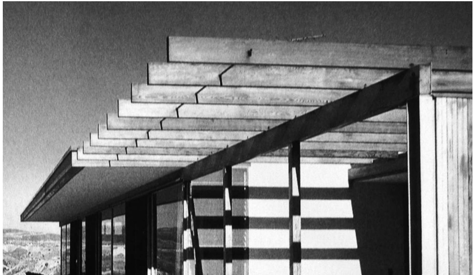
FIG. 1.019: DETALLE DE CUBIERTA / FOTO SCHULMAN.
