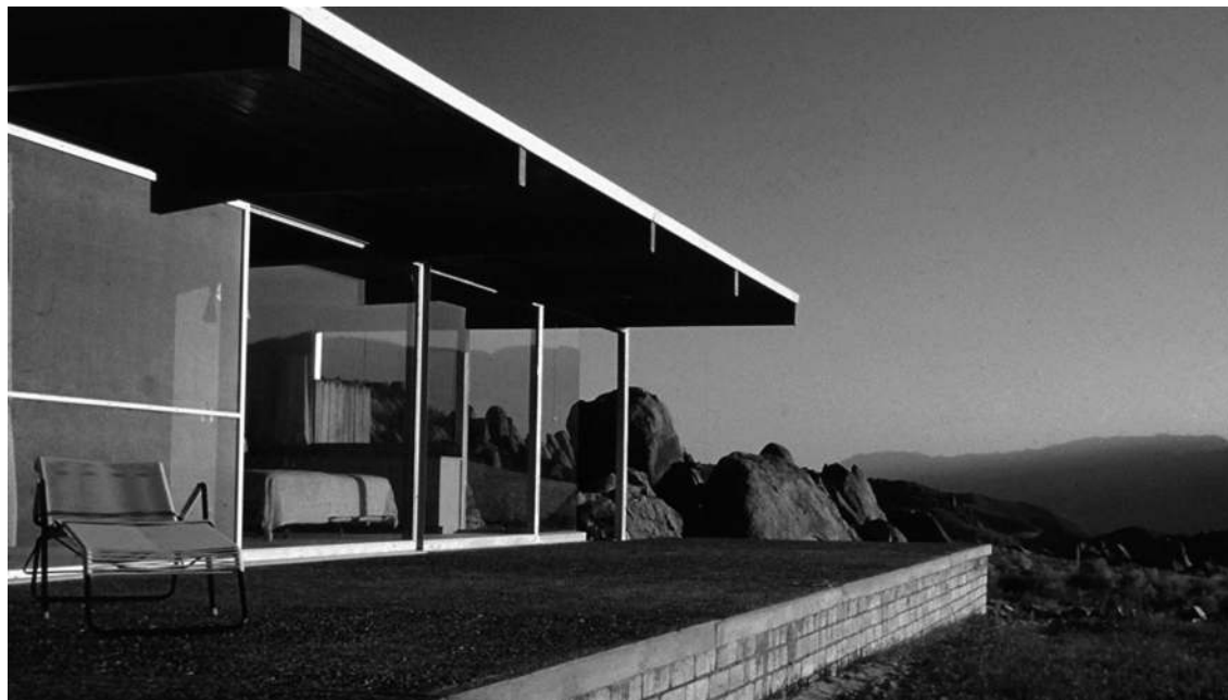
FIG. 947: VISTA LATERAL / FOTO SCHULMAN.
