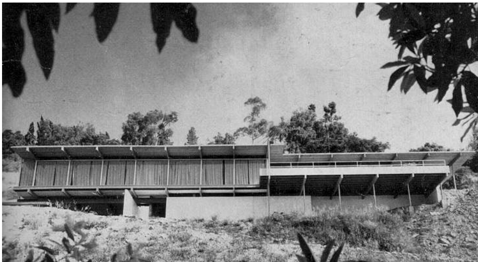
FIG. 643: FACHADA POSTERIOR / FOTO SCHULMAN.
