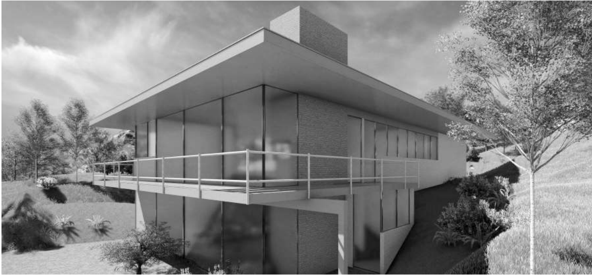
FIG. 563: VISTA NOROESTE – FRONTAL Y LATERAL / RECONSTRUIDA / ELABORACIÓN PROPIA.
