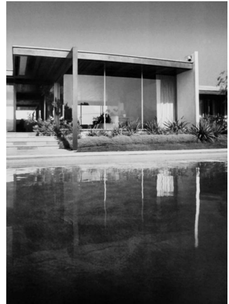
FIG. 365: EXTERIOR FACHADA PRINCIPAL / FOTO SCHULMAN.
