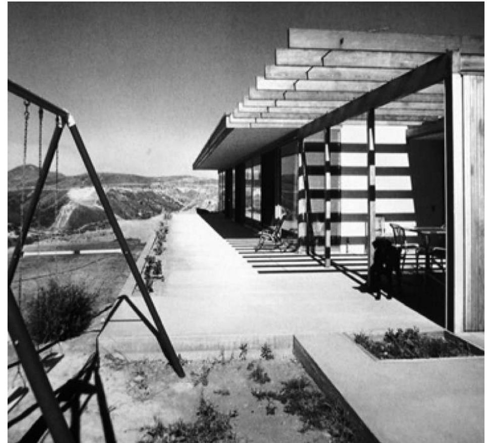
FIG. 1.004: FACHADA POSTERIOR Y TERRAZA / FOTO SCHULMAN.
