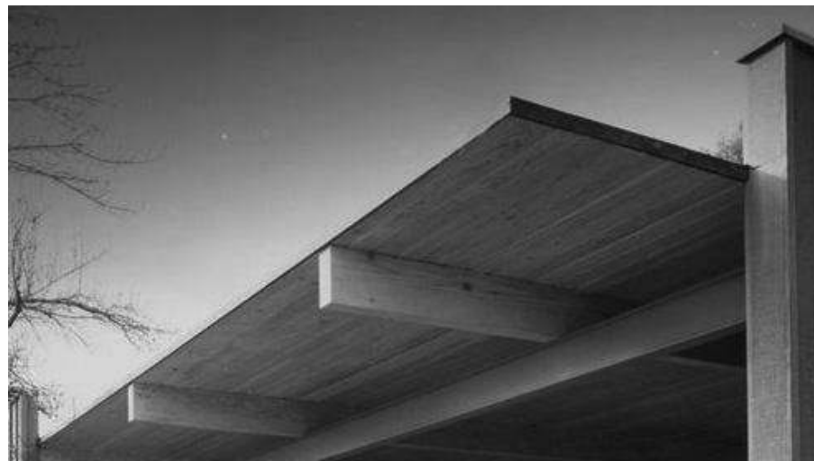
FIG. 287: DETALLE INTERIOR Y EXTERIOR DE CUBIERTA / FOTOS SCHULMAN.
