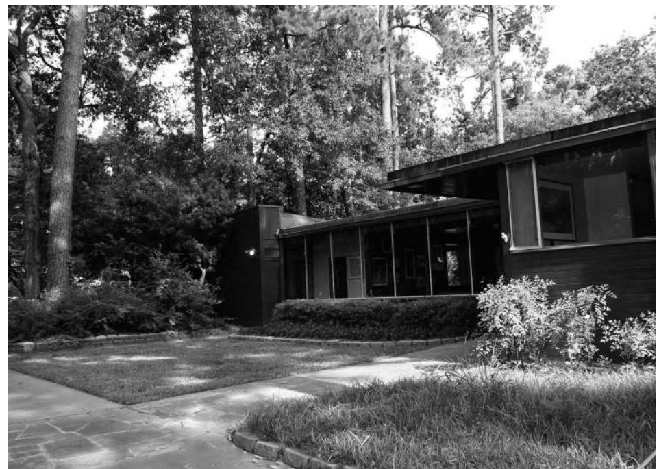
FIG. 91: VISTA EXTERNA / FOTO SCHULMAN.
