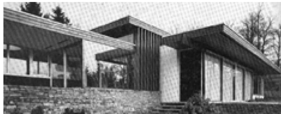
FIG. 1.181: FACHADA LATERAL / FOTO SCHULMAN.
