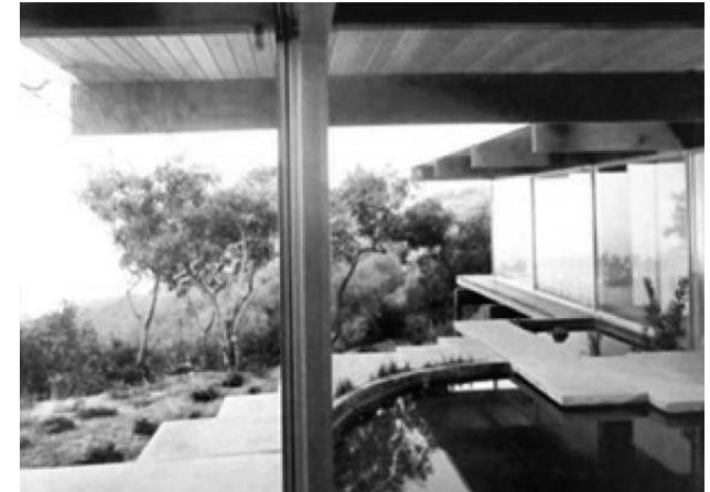
FIG. 680: DETALLE DE PILAR / FOTO SCHULMAN.
