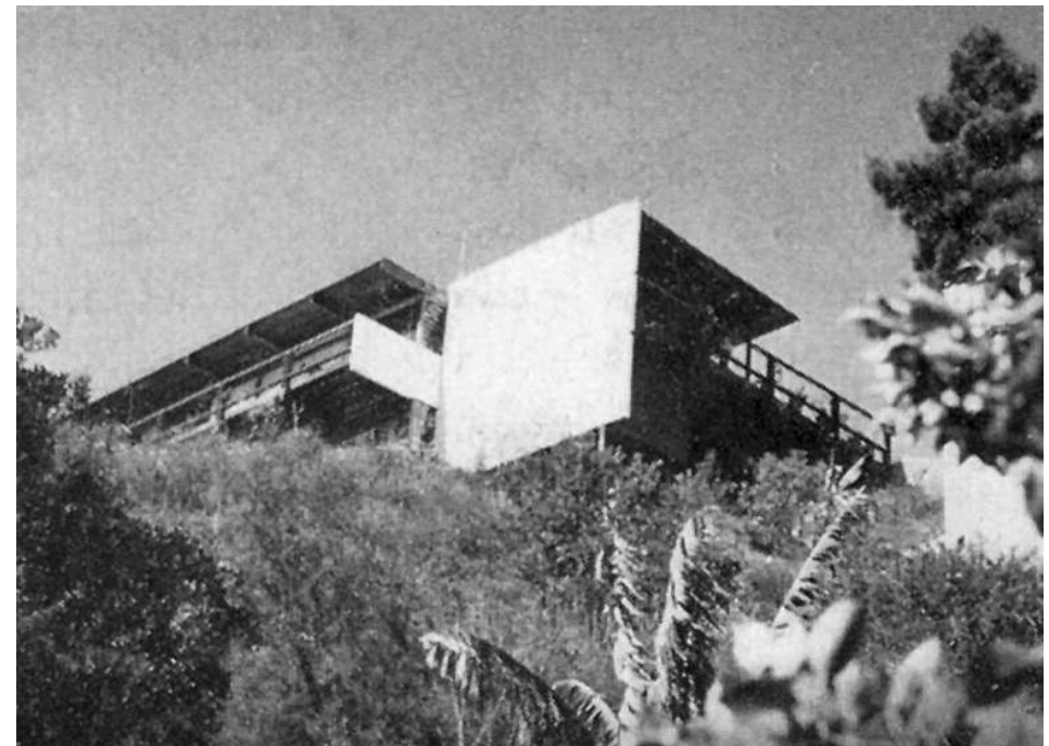
FIG. 400: FACHADA FRONTAL Y LATERAL / FOTO SCHULMAN.
