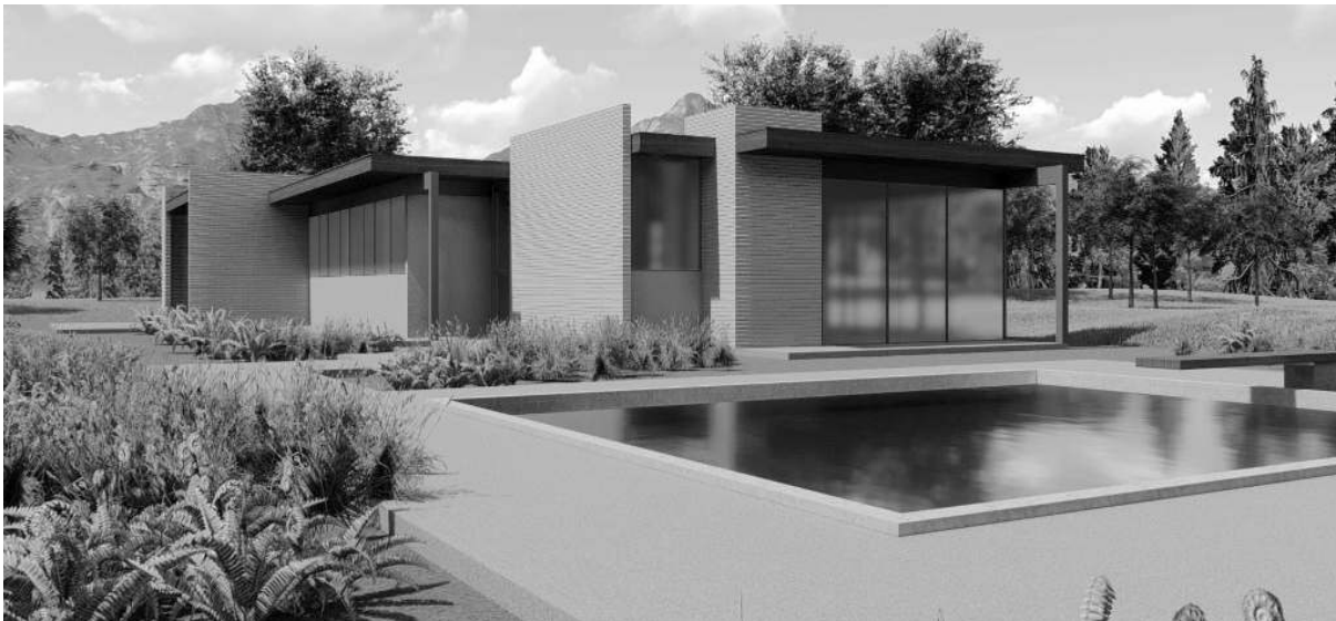
FIG. 160: VISTA SUR – LATERAL – DETALLE VIGA Y PILAR / RECONSTRUIDAS / ELABORACIÓN PROPIA.
