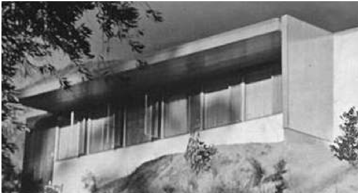
FIG. 720: DETALLE DE CUBIERTA / FOTO AMPLIADA SCHULMAN.
