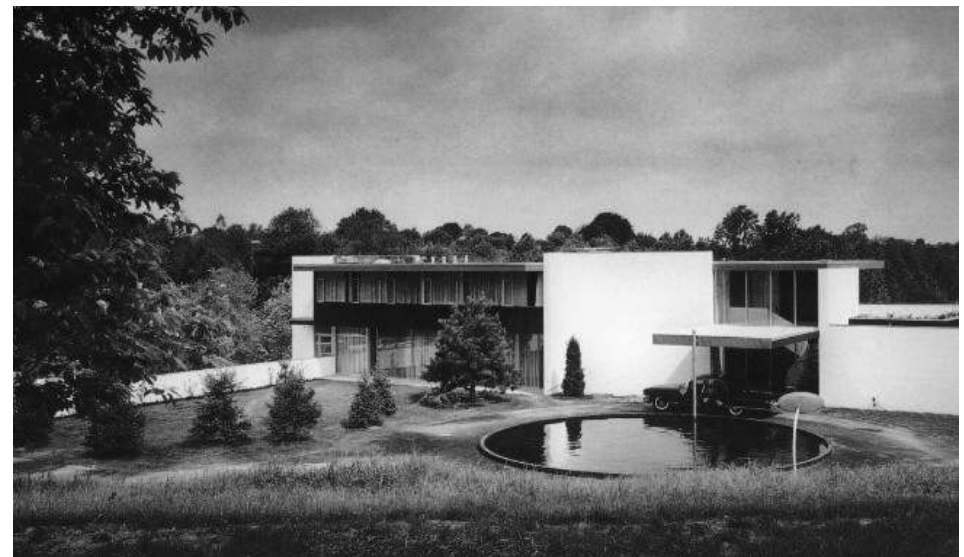
FIG. 780: INGRESO PRINCIPAL / FOTO SCHULMAN.
