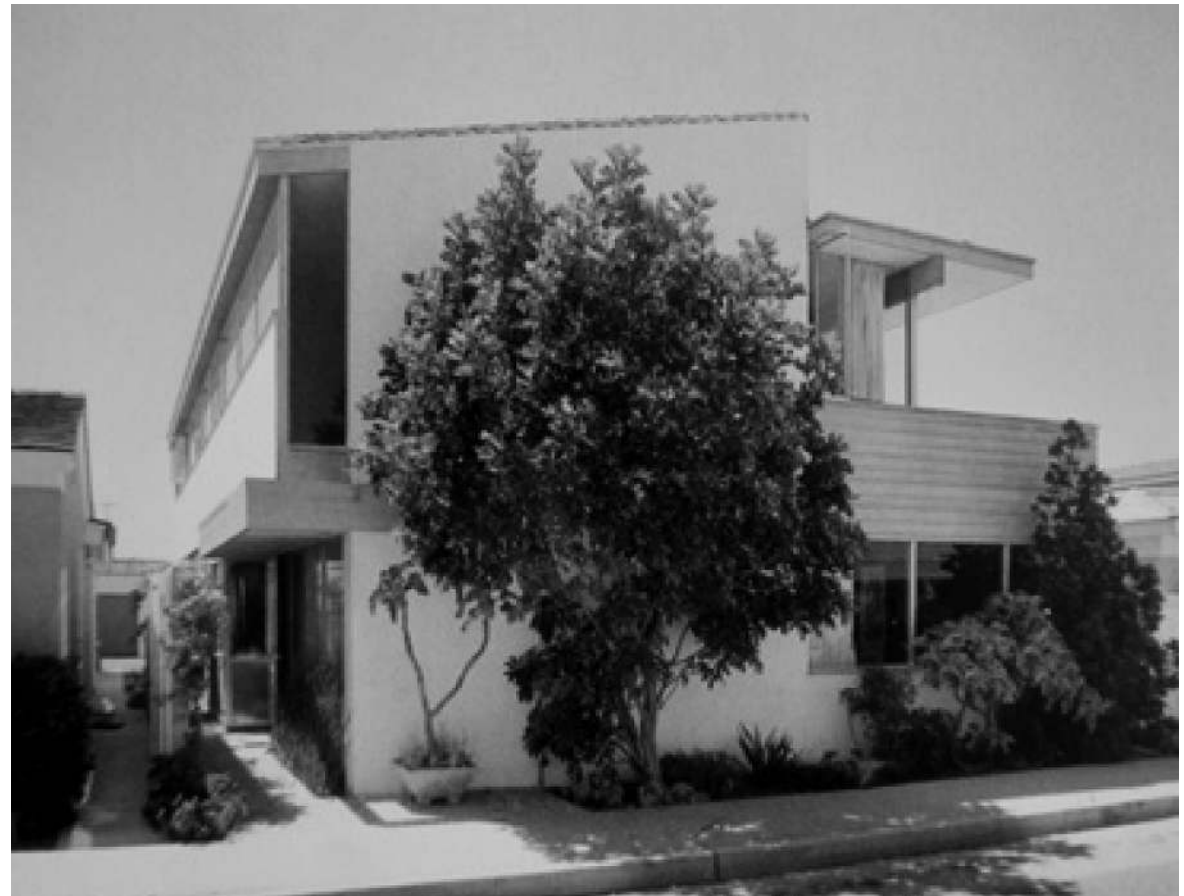
FIG. 1.056: FACHADA FRONTAL - INGRESO / FOTO RICHARD NEUTRA.
