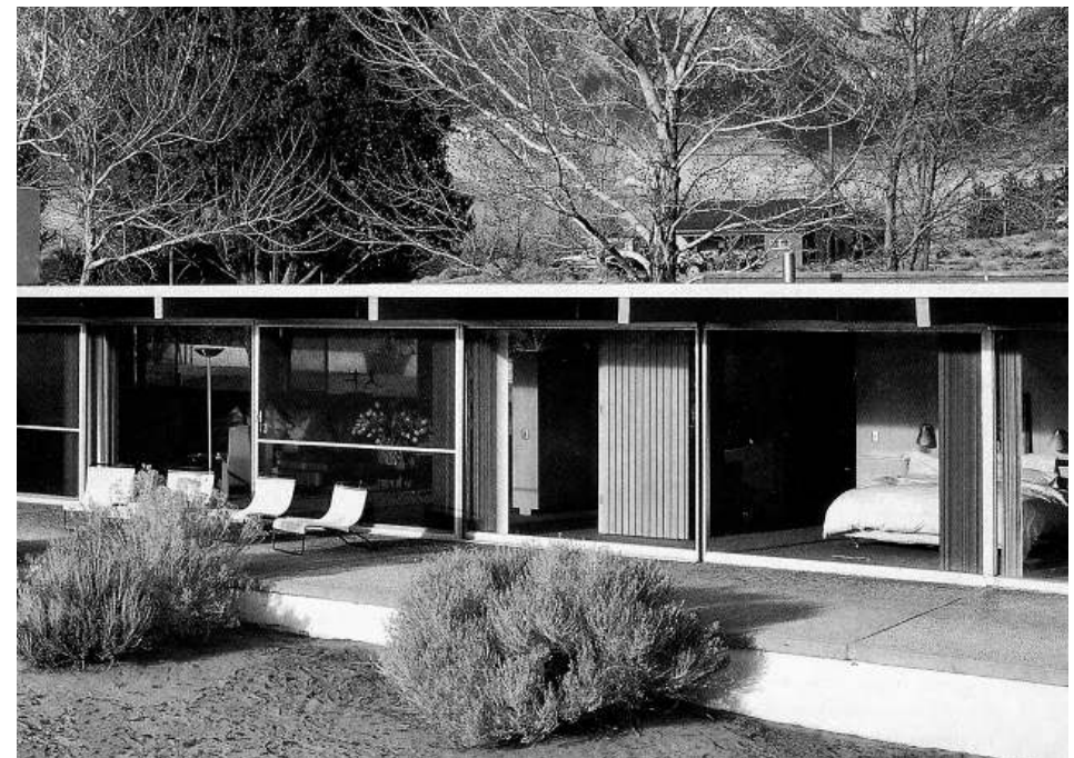
FIG. 932: FACHADA POSTERIOR / FOTO SCHULMAN.
